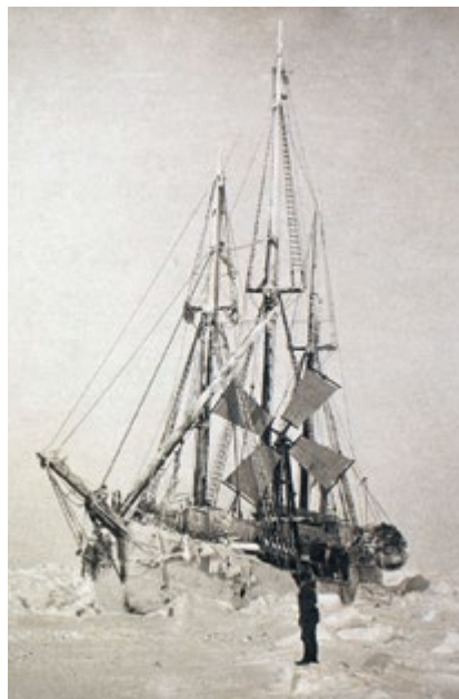
Судно «Фрам» в марте 1894 г. Хорошо виден ветряк электрогенератора
